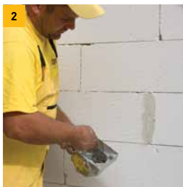
2. Murit Ytong duhet paraprakisht t'i mbulohen hapjet me masë llaçi, shtresa e hollë shpërndahe me rrafshuese me thellësi dhëmbzori 10mm
